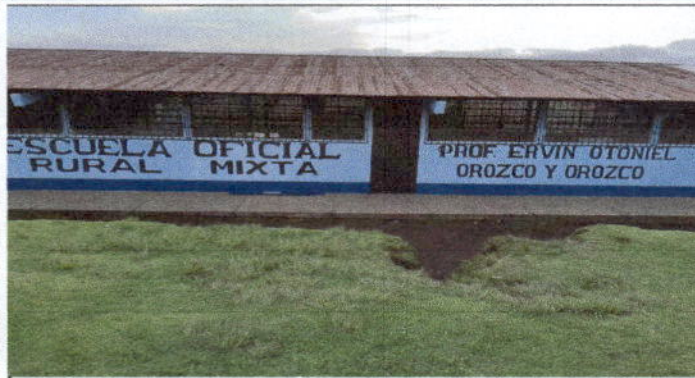
Foto1: Pintura de muros exteriores e interiores.
