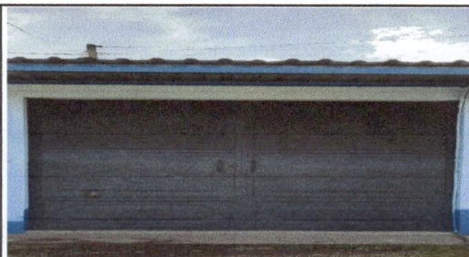
Foto 4: Remodelación de puerta del comedor, de dos hojas (Ancho 2.50, alto 2.18 mts).
