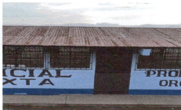
Foto 2: Cambio de puertas deterioradas
