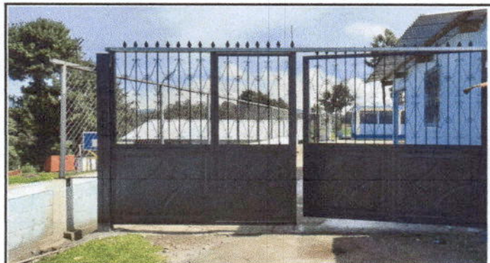
Foto 3: Instalación de portón principal y colocación de malla perimetral. (La malla se colocará sobre el muro)
