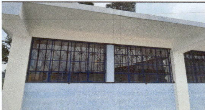
Foto 1: Instalación de balcones nuevos.
