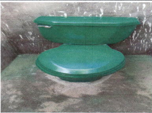
Foto 3: Instalación de inodoro
