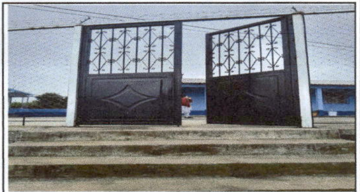
Foto 2: Instalación puerta de acceso a la cancha polideportiva
